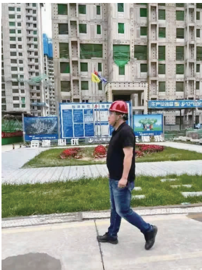
刘轶在施工现场。
