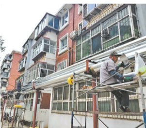
平安小区南区更换后的供热管网保温层。
